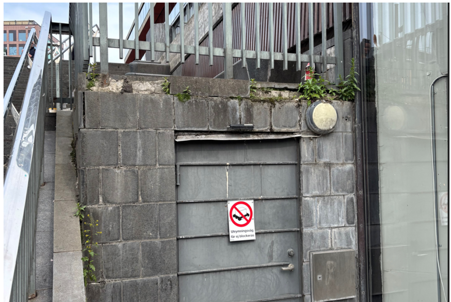
Skador på fasad vid utrymningsdörr
